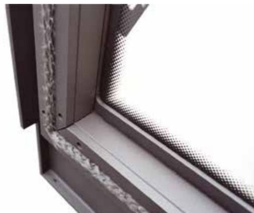
Die Tür ist verstärkt mit Vierkantrohren und mit einer integrierten Abdichtungslitze versehen.
